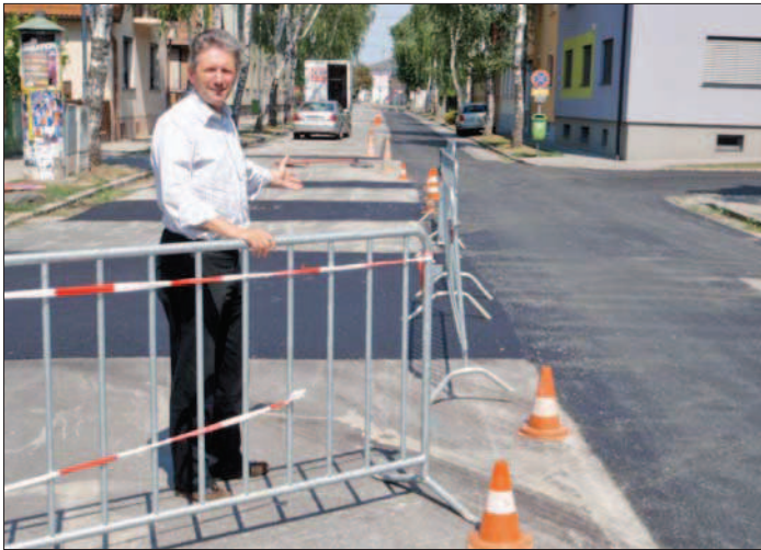
Bgm. Quirgst: „Die vielen Schadstellen in der Bahnhofstraße konnten kostengünstig saniert werden.“
